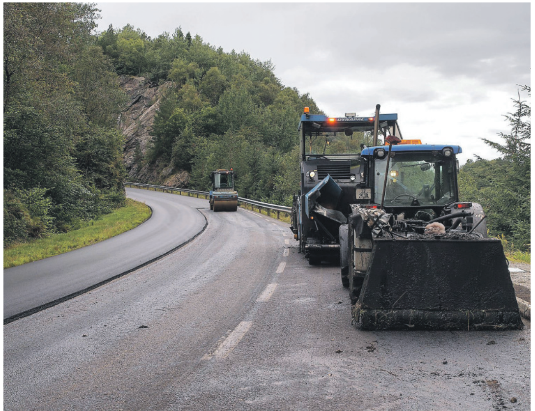
NYTT DEKKE: Måndag asfalterte NCC strekninga mellom Lukksund bru og Stussvikhovdatunnelen på fylkesveg 49.
